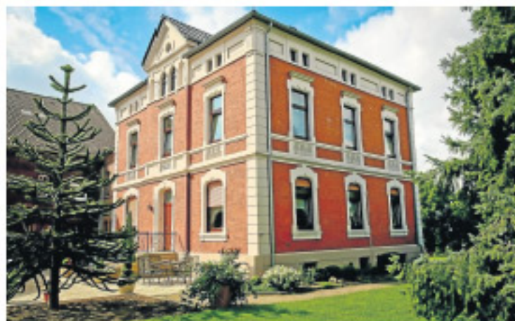
Auch das Haus an der Oberevinger Straße 133 wurde prämiert.
